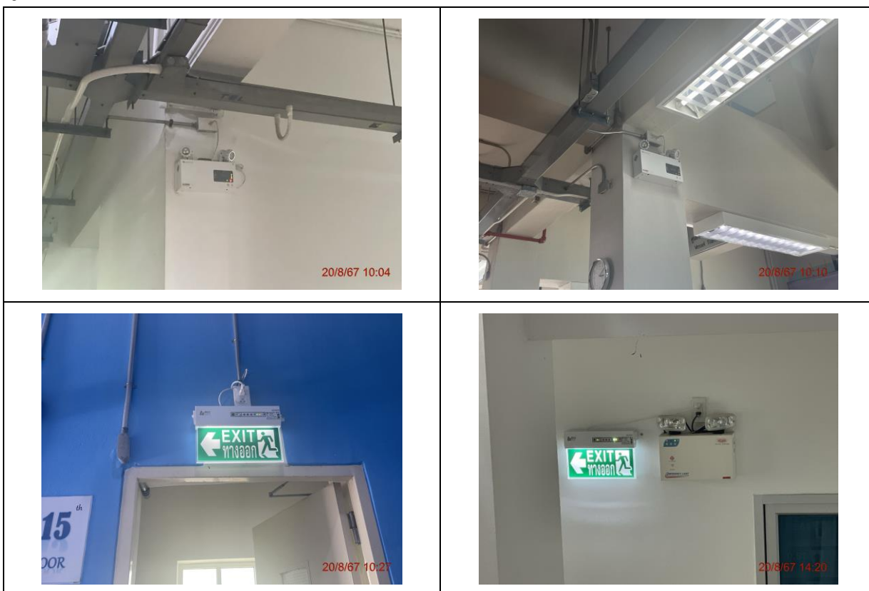
รูปที่ 10 ไฟฉุกเฉิน และป้ายทางออก
